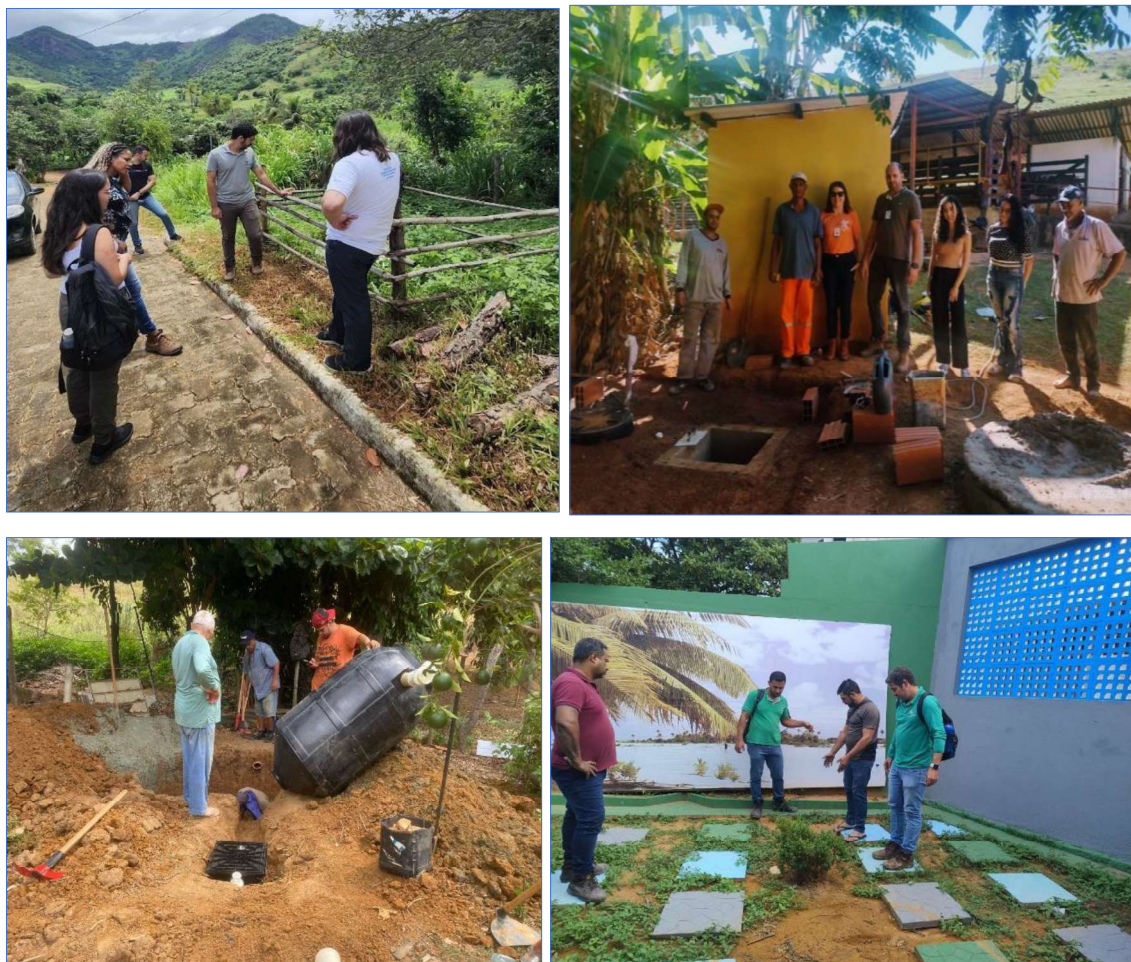
Figura 71 – Visitas técnicas para monitoramento de obras e outros serviços – Ciclo III
