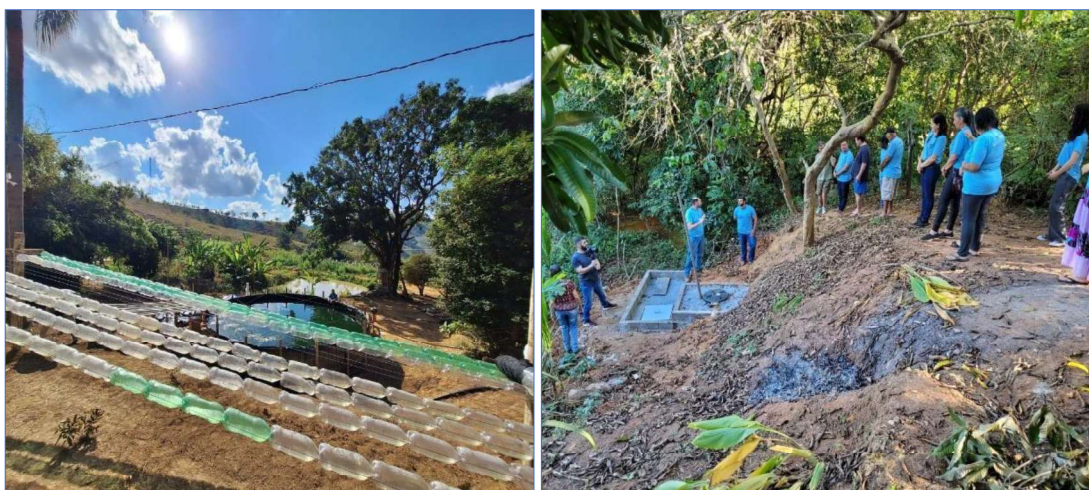
Figura 70 – Visitas técnicas para monitoramento de obras e outros serviços – Ciclo II
